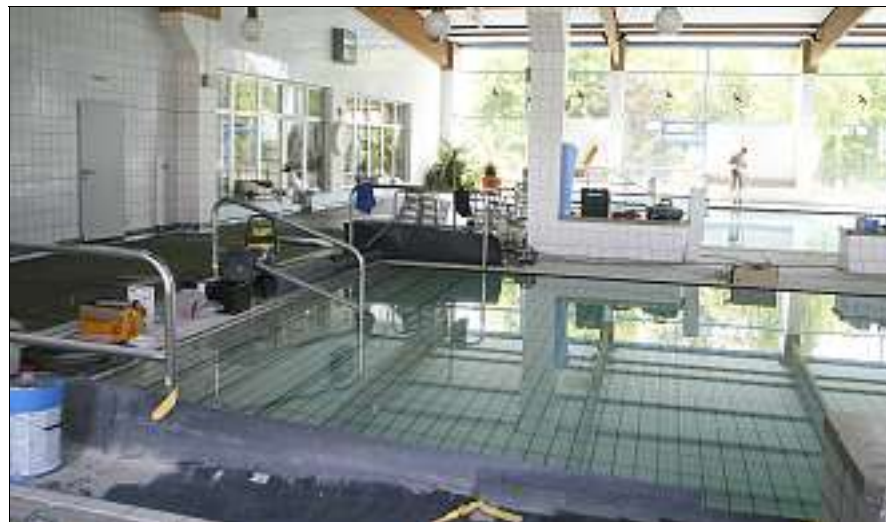
Auch in der Schwimmhalle laufen Bauarbeiten, die allerdings nichts mit der Flut zu tun haben. Unter anderem werden Fliesen erneuert.
